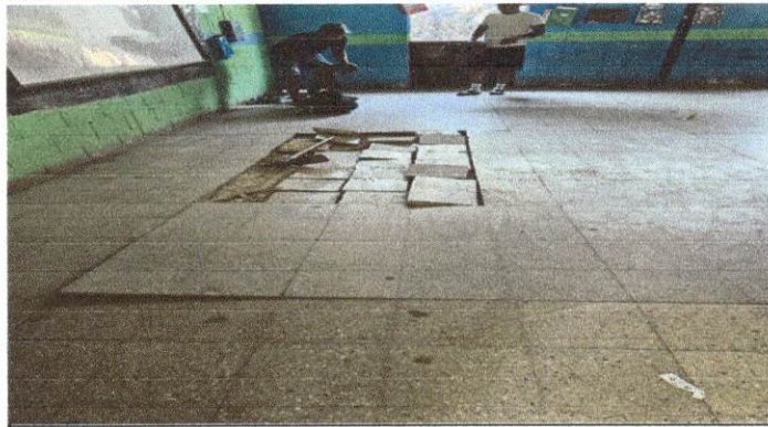
Foto1: Sustitución de piso de granito
