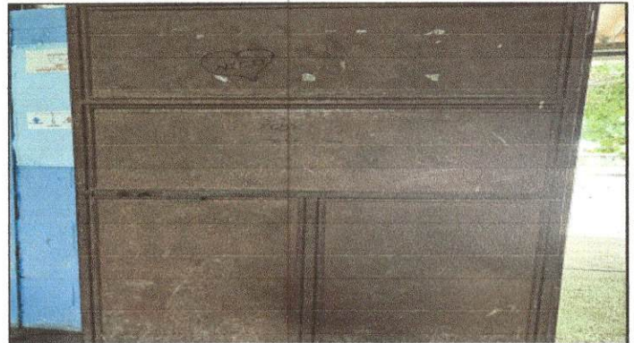
Foto 4: Mantenimiento a puertas
