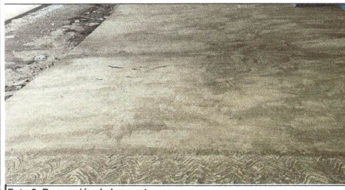
Foto 5: Reparación de banqueta
